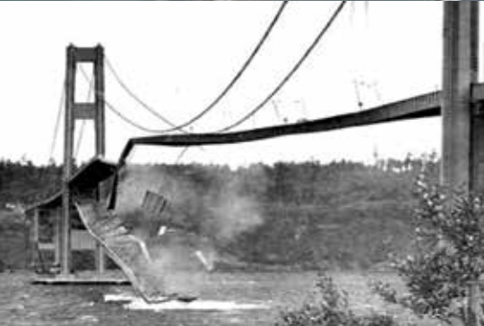
Разрушение таномского моста Collapse of Tacoma Narrows Bridge
